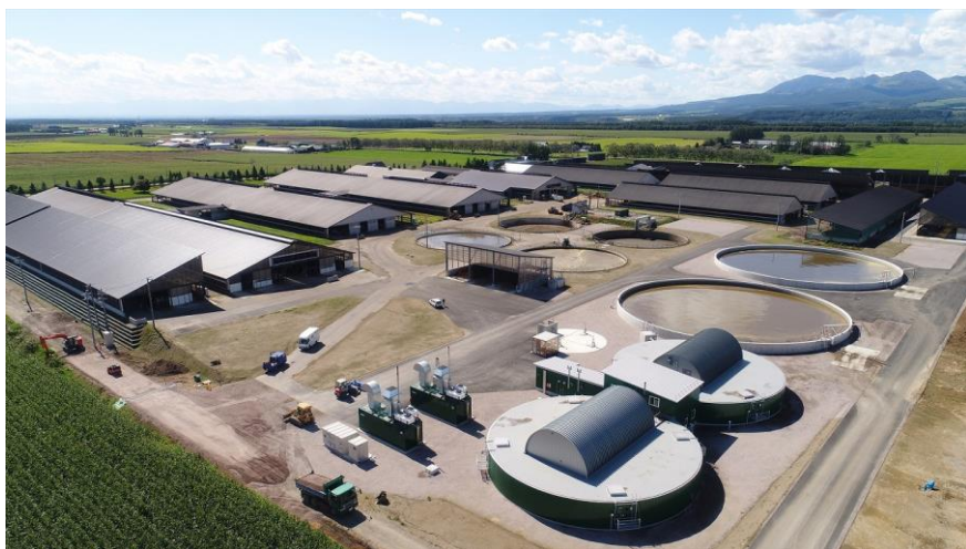
バイオガスプラント
