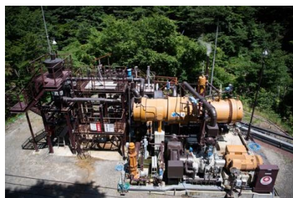
地熱発電設備 出所:元気アップつちゆHP
