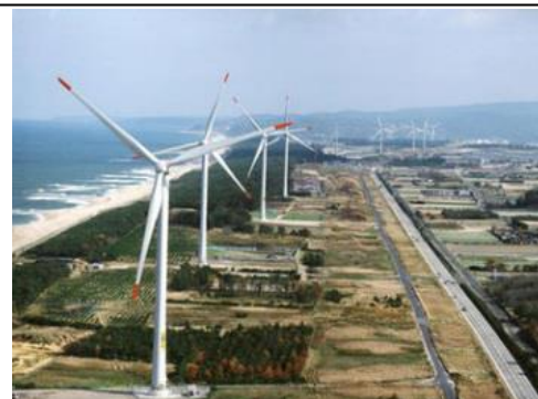
北条砂丘風力発電所 (鳥取県北栄町：1,500kW×9基)
