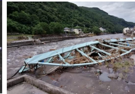
令和2年7月豪雨 大分県日田市の流された橋
