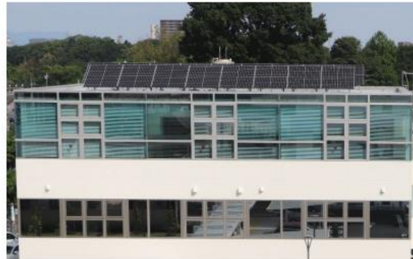
太陽光パネルの設置
