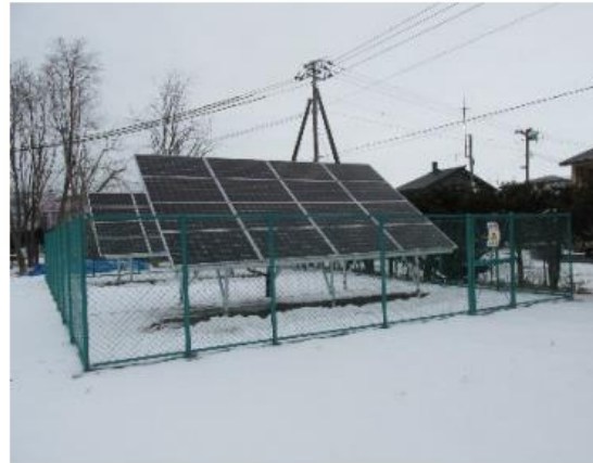
太陽光パネルの設置
