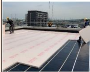
屋根の高断熱化
