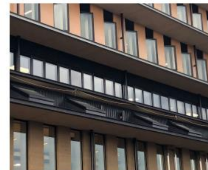
光ダクトシステムの採用
