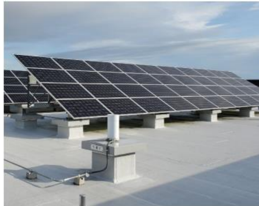
太陽光パネルの設置
