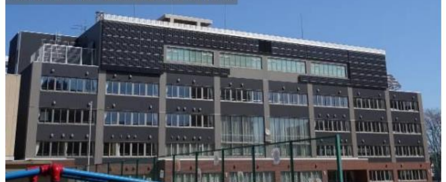
北九条小学校 壁設置型太陽光パネル
