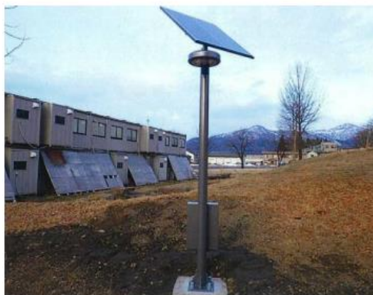
市役所庁舎敷地内にソーラー街路灯を設置
