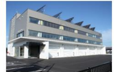
導入施設: 白糠消防庁舎
