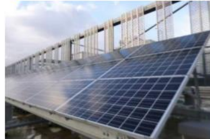
太陽光発電システム(10kW)
