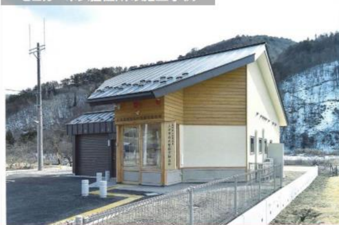
ゼロカーボン駐在所の施工事例
