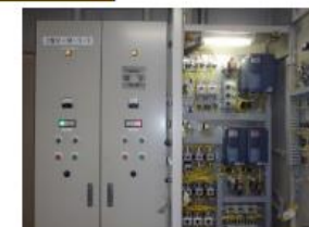
給排気ファンのインバータ制御
