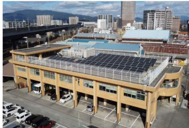
環境部庁舎全景
