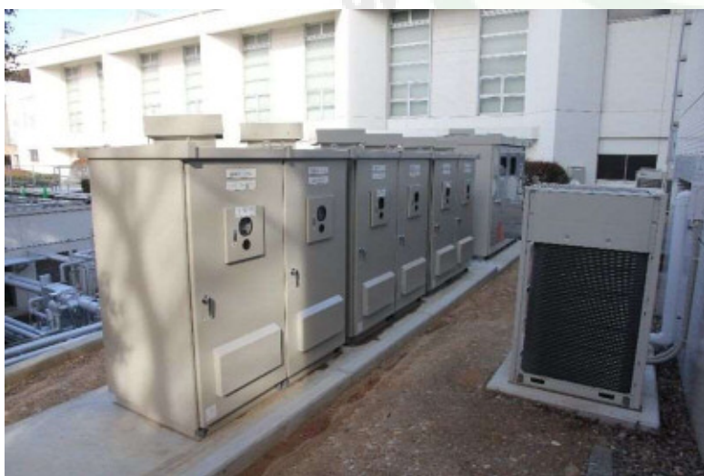
【蓄電池設備 90 kWh 出力30 kW】
