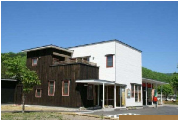
H24一の橋住民センター
