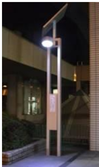
太陽電池式LED照明灯
