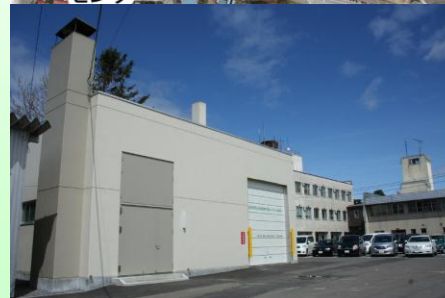
役場周辺熱供給施設
