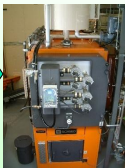
木質ボイラー
