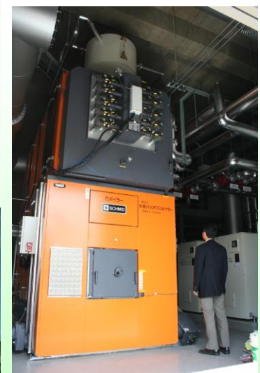
木質ボイラー
