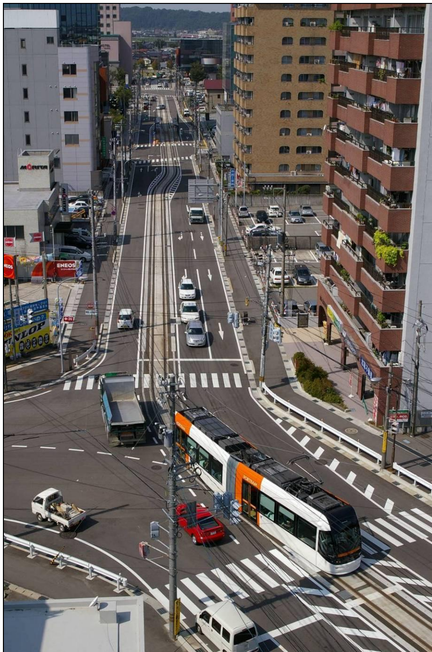
■ 軌道区間（都市計画道路綾田北代線）
