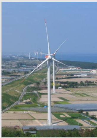
（出典）北栄町，北条砂丘風力発電所
