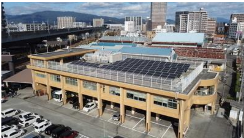
図3 『ZEB』改修後の環境部庁舎全景
