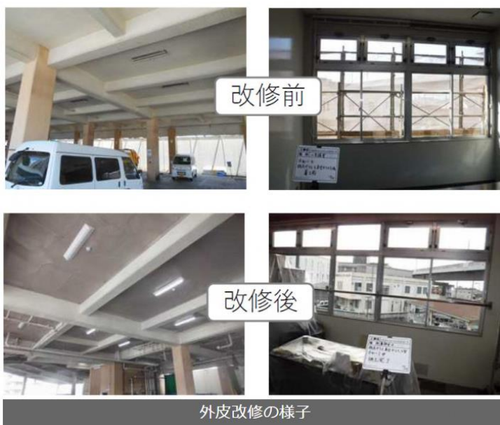
図4 外皮改修工事の様子
