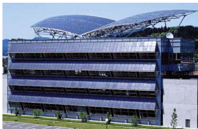
図 18 北広島庁舎の太陽光発電システム
