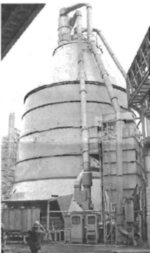
真庭市の銘建工業では、木のチップによる発電施設を持つ。燃料を貯蔵する巨大なサイロ
