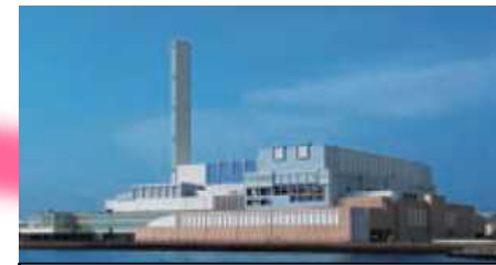
バイオマス発電(ごみ処理) (約3.2億kWh)
