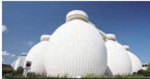
バイオマス発電(下水処理) (約4,900万kWh)
