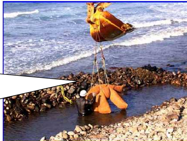
製鋼スラグと腐植物質を活用した実証試験
