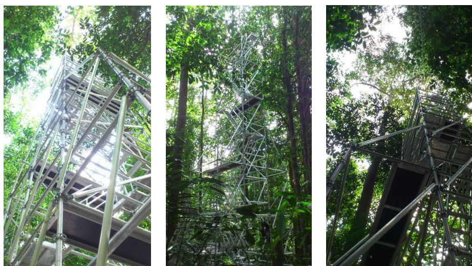
図1. FRIM内に建設した林冠アクセスタワー
