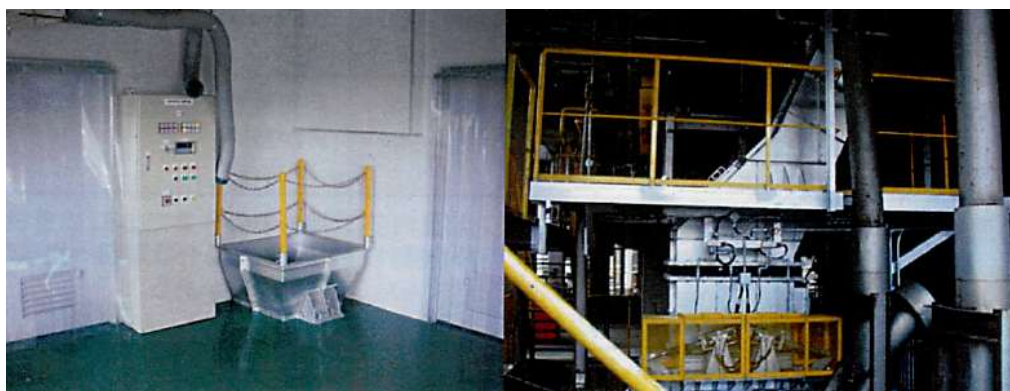
図2 2 負圧に維持された中で投入作業を行う投入管理室（左）と装置内が負圧に維持されている自動投入装置（右）。投入された廃棄物の重量管理。
