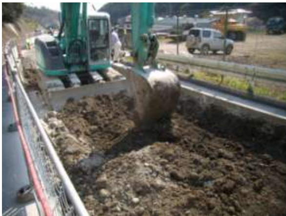
図 4.2-26 施工写真：土と改良材を混合している様子（桐生）
