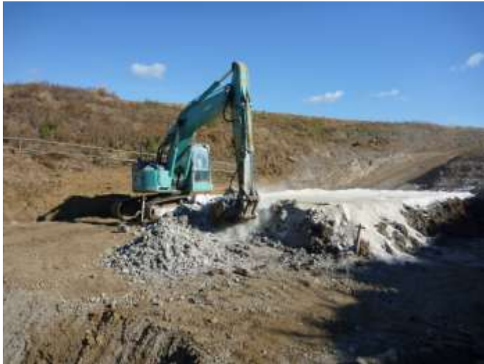
図 4.2-13 実施工での混合攪拌の様子
