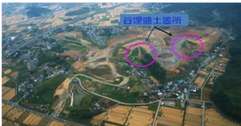
図 4.2-1 造成現場の航空写真（左○が盛土部 A、右○が盛土部 B）
