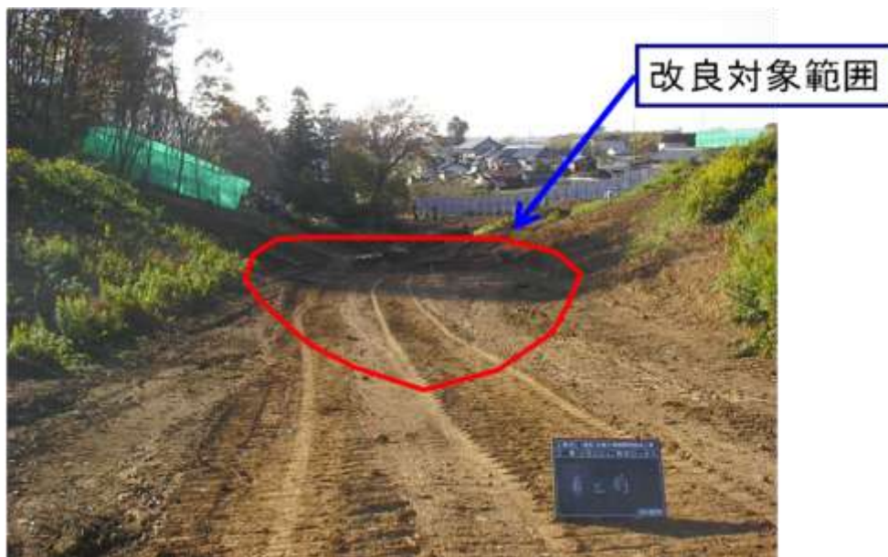
図 4.2-12 盛土部Aの施工箇所（施工前）
