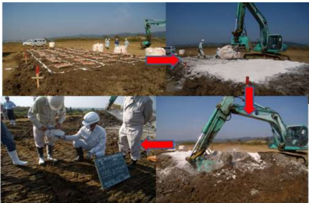
図 4.2-10 試験施工の様子とコーン貫入試験による強度測定
