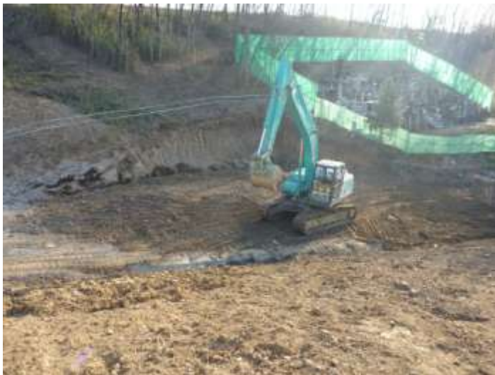
図 4.2-14 実施工での転圧の様子
