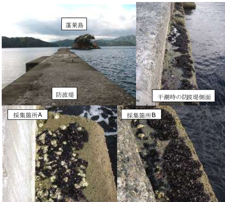
写真 2-1-1. 海産汚損生物の 付着状況
