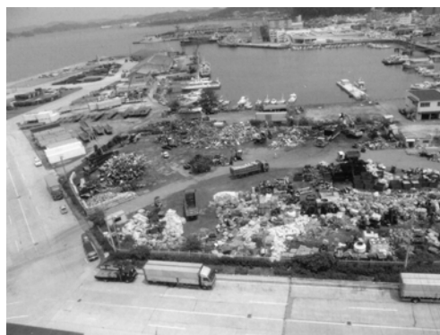
図 3.1.8 火災が発生した集積場
