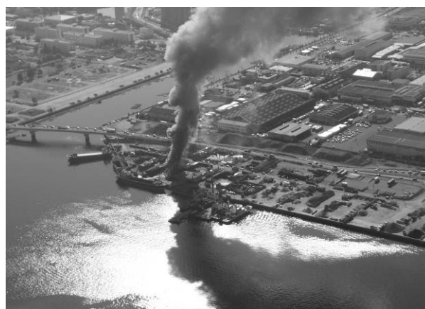
図 3.1.12 広島港内陸上施設火災（2010.9）
