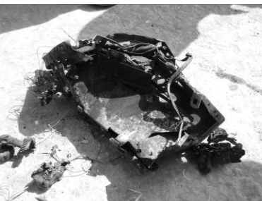
図 3.1.44 出火元と された UPS
