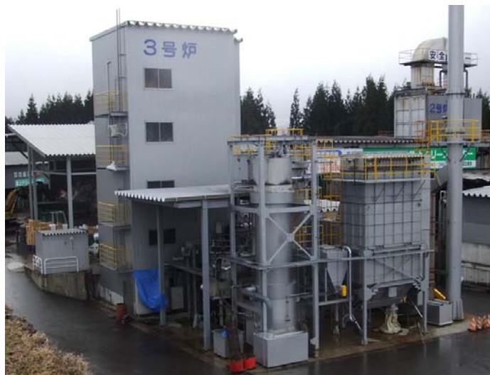
写真-1. 実証試験装置全景
