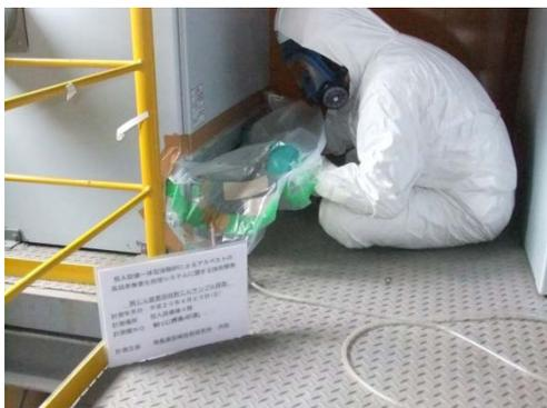
写真-7.4.1 ドギーバッグでの作業状況
