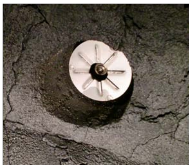
写真-6.2.2 先端当板付き広ピッチスクリュウコンベア 吐出口部分(鳥瞰、設置時)
