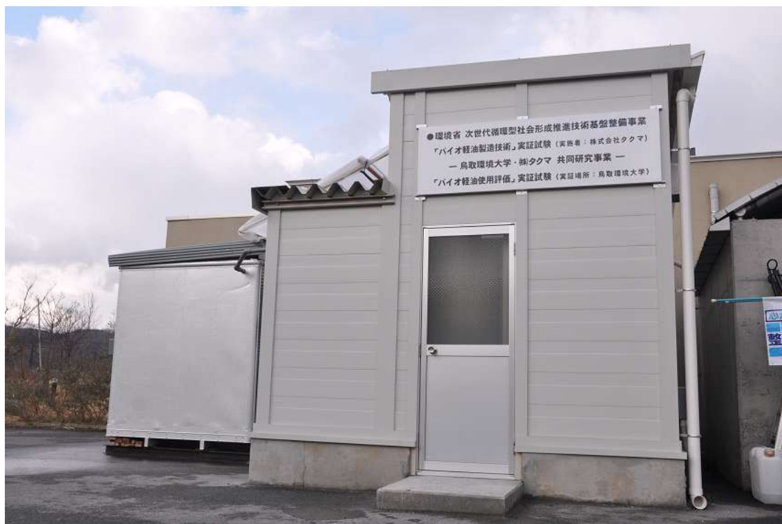
図 4 実証設備設置場所の外観
