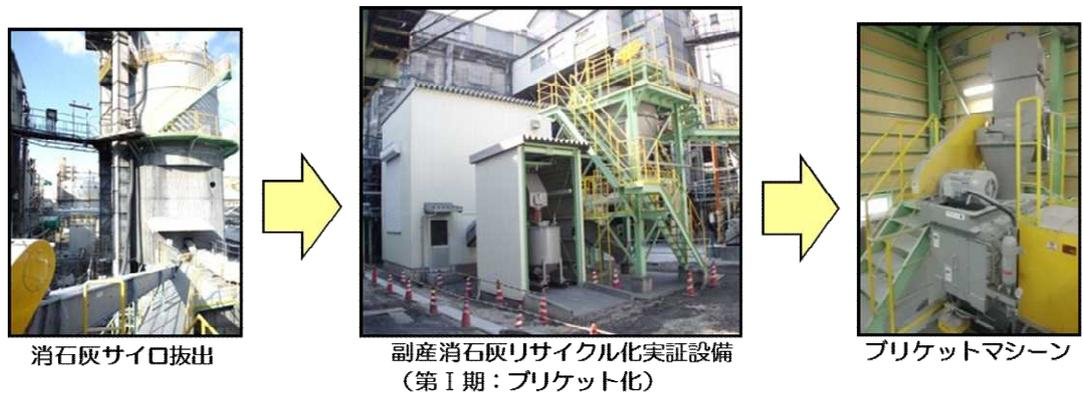
図.3 補助事業設備(消石灰サイロ拔出～ブリケットマシン含む)
