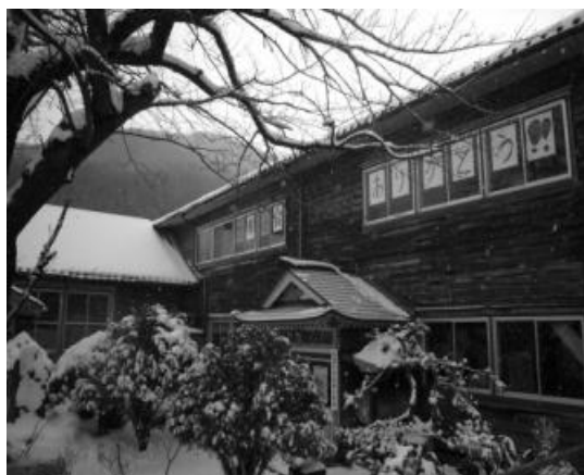
写真4. 旧岩首小学校校舎を活用した岩首談義所
