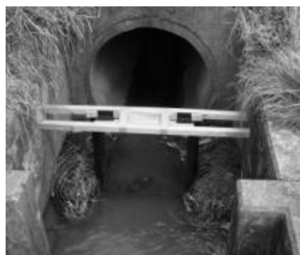
図5. 水路の入り口に設置されたPITタグ読み取り機. PITタグを保持した個体が通過すると記録される.
