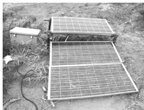
図22. 増設した電源モジュール。
