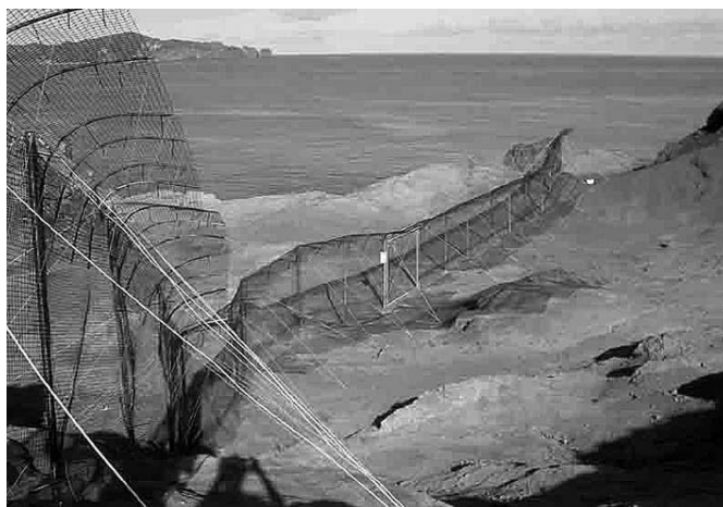
図4. 母島南崎に設置した海鳥繁殖地保護のためのネコ侵入防止柵。
