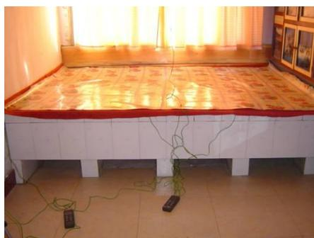
写真7 架空炕 (熱効率70%改良型炕) 19)
