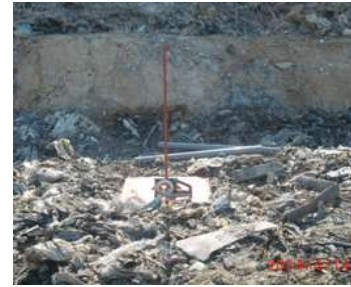
図 37 廃棄物地盤上への沈下板の設置
