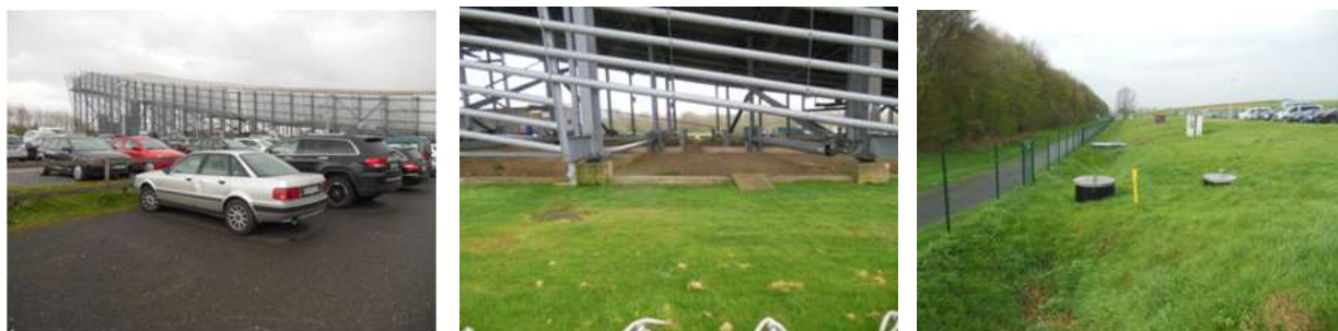
図 124 ドイツ・ノイス グレーフラート埋立地に建設されている人工スキー場
