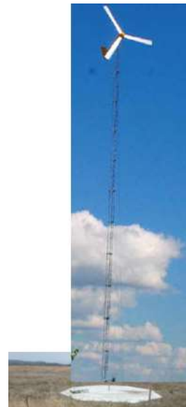
図125 想定した小型風力発電設備 h=30m (Excel10 by TenArrows)
