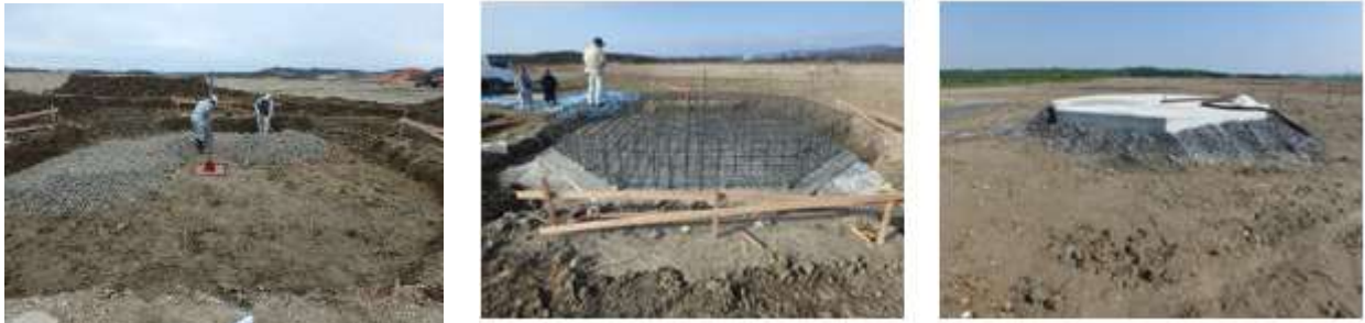
図 131 小型風力発電設備基礎相当のコンクリート版の施工
