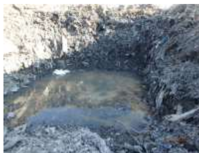
図 88 約6時間後の内部水位より25m高い位置での出水
