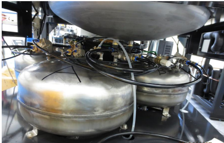
⑥ 再生溶剤貯留タンク
