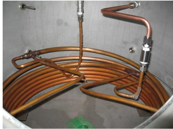
廃溶剤加温熱交換器
