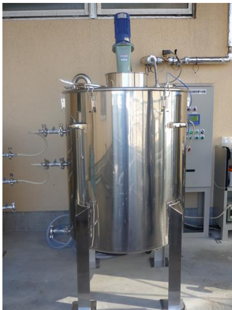
図 8-2 主発酵槽の外観 (左図) と 設置配管・機器類 (右図)
