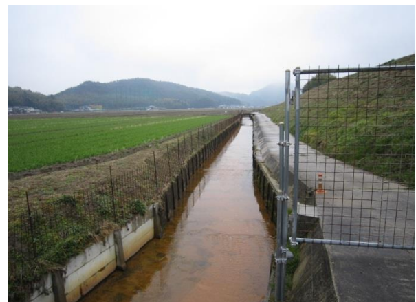
写真(1)-3 藤間川における試料採取地点の状況
