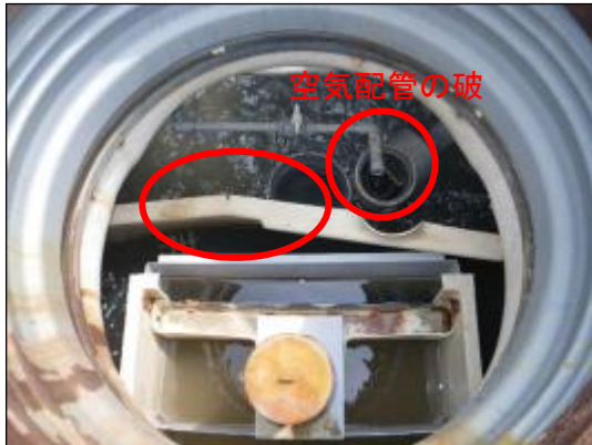
写真 仕切り板の変形・亀裂
