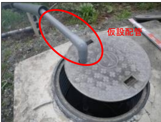
写真 3-3-11 放流ポンプ配管の応急修
