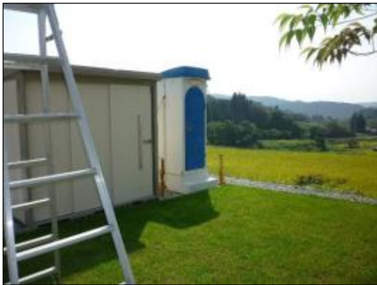
写真 3-3-9 仮設トイレの設置
