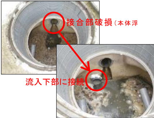
写真 3-3-7 導入管の応急修理
