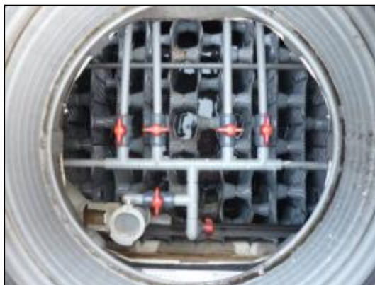
写真 漏水による水位低下
