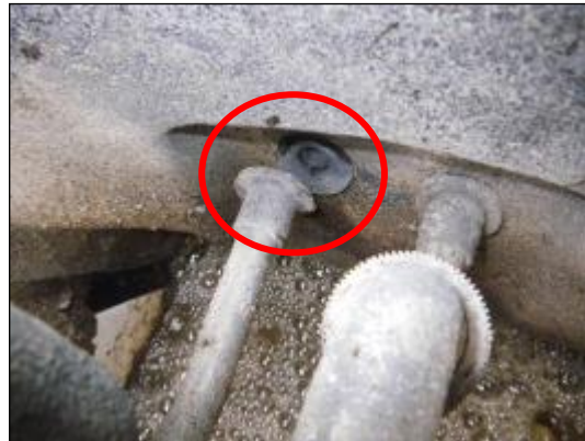
写真 槽内空気配管の破損
