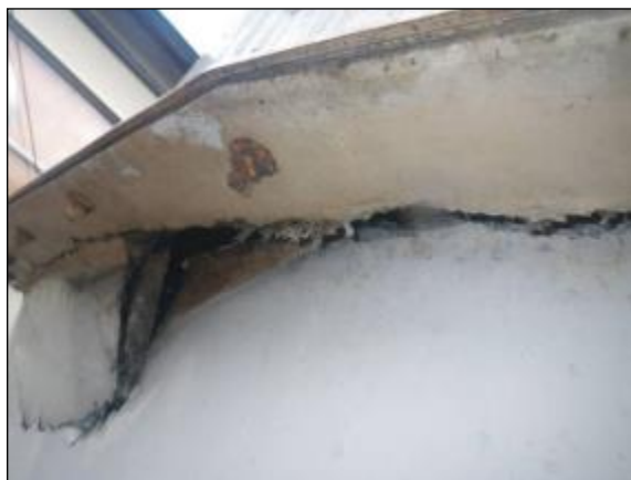
写真 躯体の大きな破損
