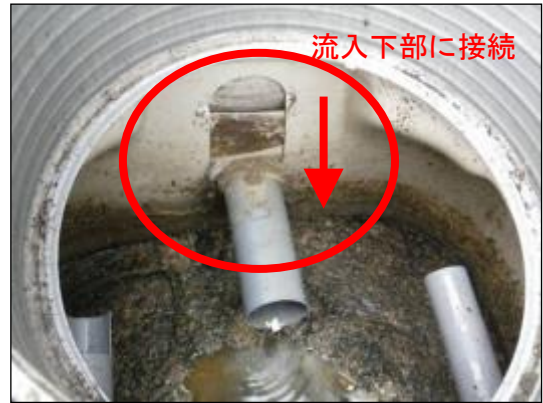
写真 3-3-8 導入管の応急修理 2
