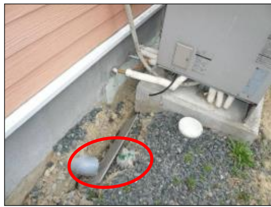
写真 流入管の破損
