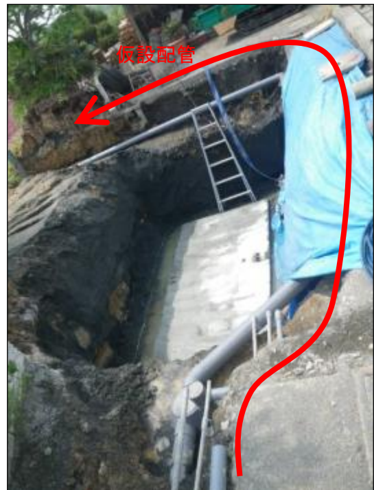
写真 3-3-10 雑排水の切り回し工事
