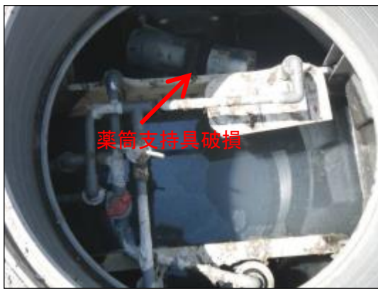
写真 消毒筒受け部の破損
