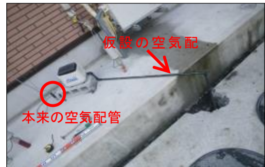
写真 3-3-12 空気配管の応急修理
