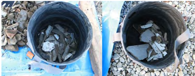
図 4.2.3 粗選別で選別したアスベスト含有建材
