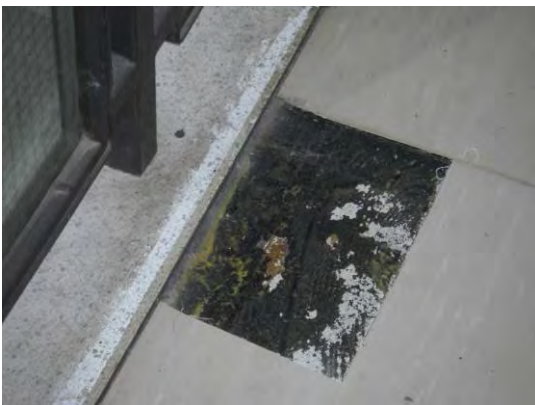
図 2.1.3 中央階段横の廊下（ビニル床シート）
