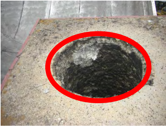
図 2.1.1 煙突内壁のアスベスト 注) 赤丸内カポスタックの可能性
