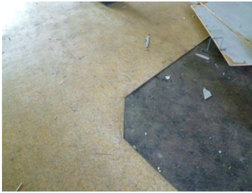
図 2.1.7 1階の階段横ロビー (P タイル)
