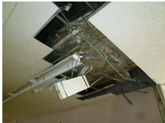
図 2.1.4 図書館入口の天井（吸音板）
