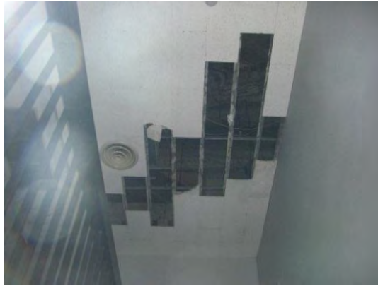
図 2.1.2 書庫 2 付近の階段上天井（吸音板）
