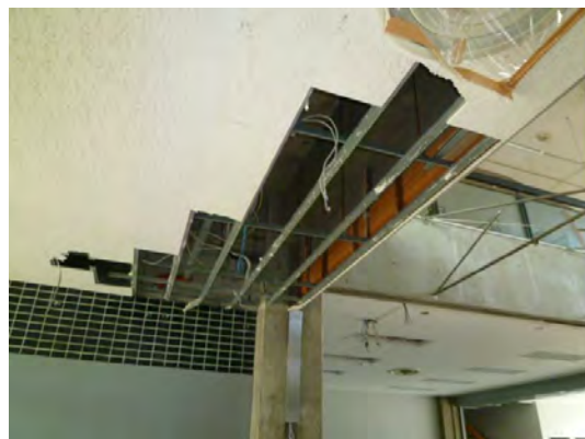
図 2.1.6 図書館ロビーの天井（吸音板）
