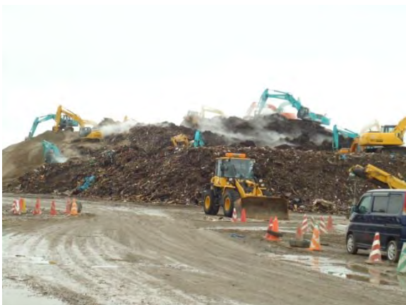
図4.5.1 名取市火災現場(平成23年9月訪問時)
