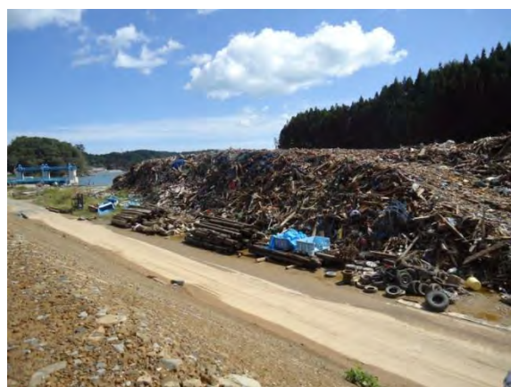
図4.5.2 南三陸町火災現場
