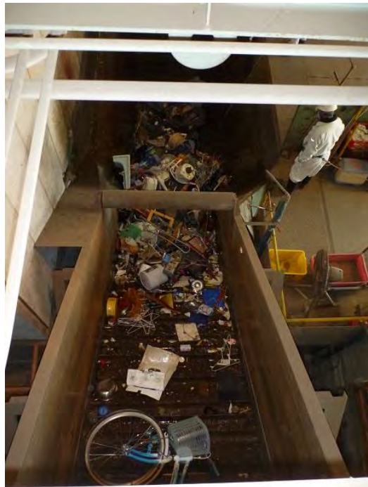
図 6.1.3 不燃ごみ・粗大ごみの処理の様子
