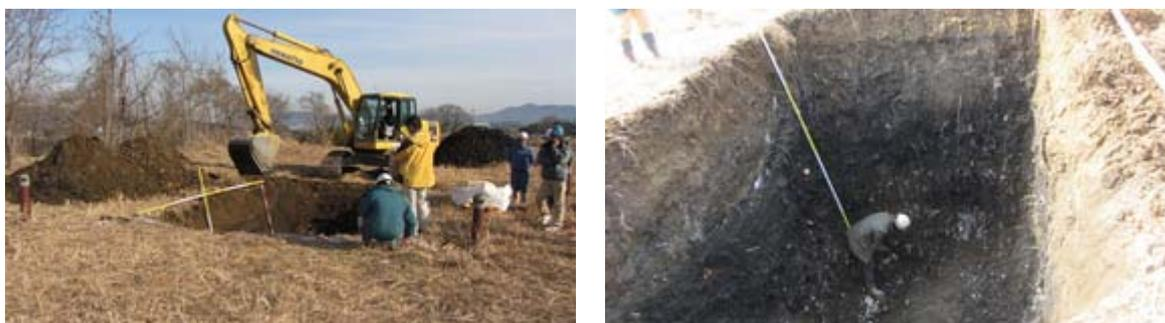
写真3 トレンチ掘削（試掘）の例
