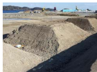
分別土砂の試験施工盛土の動態観測
