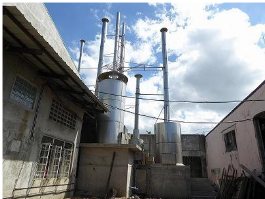
排ガス処理施設(ただし不稼働)
