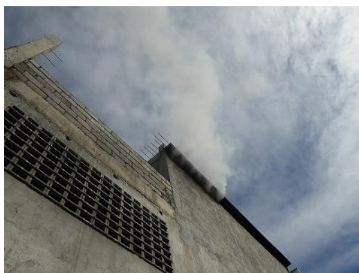
排ガス処理施設無し(煙突もなく、 最上階からNO x と煙)
