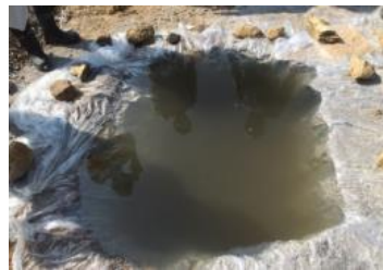
現場密度試験(水置換法)
