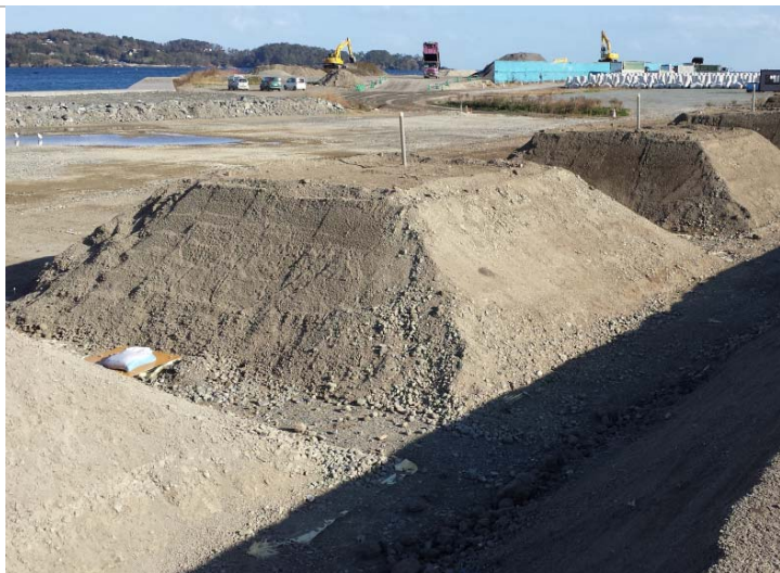
分別土砂を用いた試験施工盛土の動態観測 (国環研、岩手県、岩手大)
