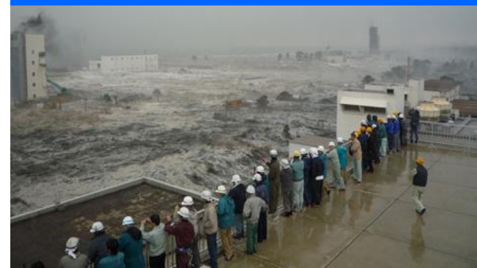
破壊された生物反応槽
