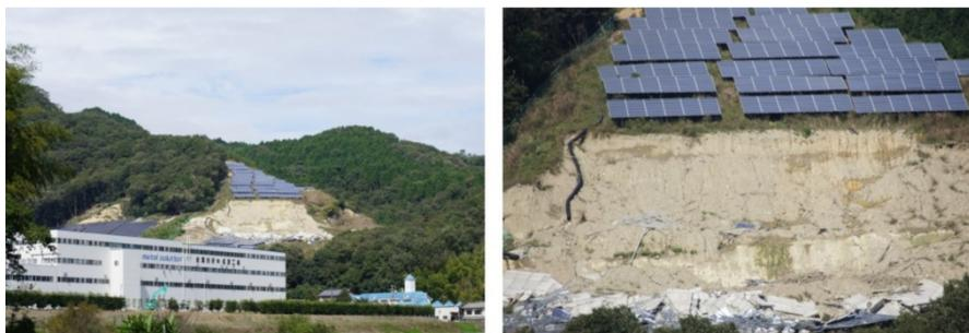
図 3.4 豪雨に伴う地すべりで崩落した太陽光発電所
