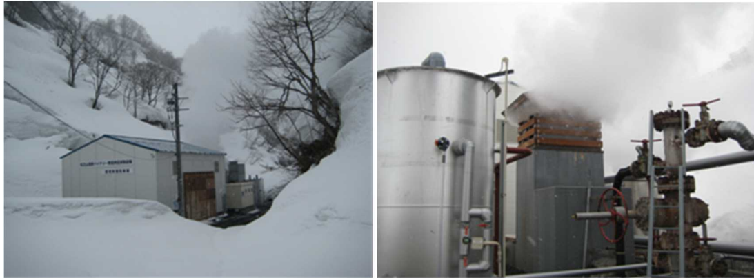
図表 134 松之山温泉バイナリーサイクル発電設備概観
