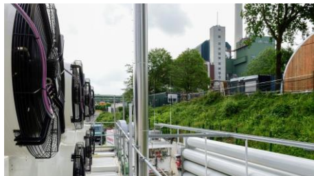
出所) AWGウェブサイト AWGごみ焼却場内のP2G設備。 コジェネの電力で水素を作り市内のバス利用
