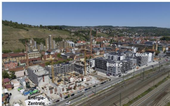
出典) Frisch, 2020 SWEがエネルギーコンセプトを開発、設計、建設中のCO2ニュートラル街区。集合住宅2棟と学校の校舎の3棟からなる。屋根上太陽光、蓄電池、P2G設備などをSWEが管理、運営する。
