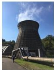
▲松川地熱発電所
