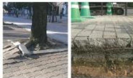
写真2-14、2-15 根上がり現象とその対策 排水用土壌が足りず、根は地表面に近い場所へ伸び、やがて根上りを起こす。植栽による歩道陥没も事故に起因するためにも、対策が必要。
