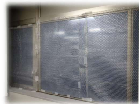
窓に気泡緩衝材を貼って断熱した例
