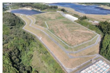
写真3-7-3 土壌貯蔵施設
