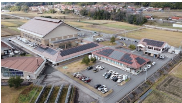
公共施設に導入された太陽光電池
