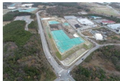
写真3-7-2 土壌貯蔵施設
